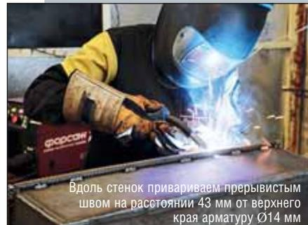
Вдоль стенок привариваем прерывистым швом на расстоянии 43 мм от верхнего края арматуру  $\varnothing 14$  мм
