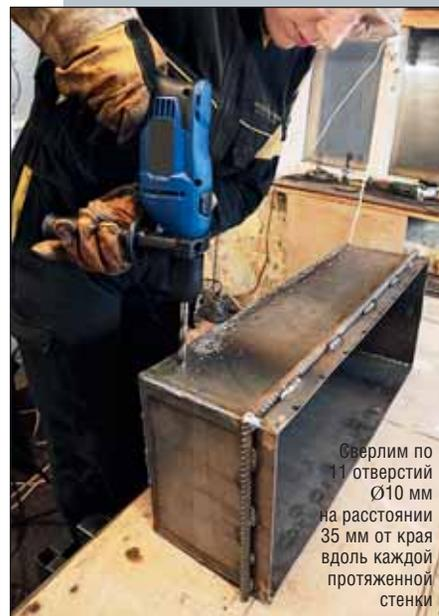
Сверлим по 11 отверстий  $\varnothing 10$  мм на расстоянии 35 мм от края вдоль каждой протяженной стенки
