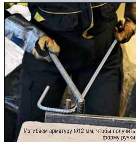
Изгибаем арматуру  $\varnothing 12$  мм, чтобы получить форму ручки
