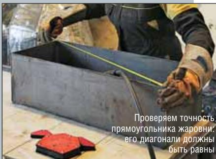
Проверяем точность прямоугольника жаровни: его диагонали должны быть равны
